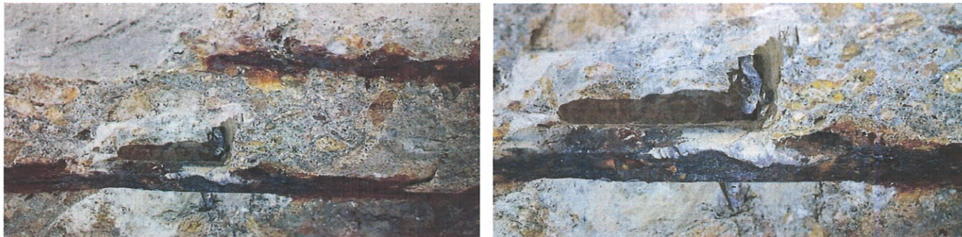
Obr. 22 a 23: kontrola dlouhodobě obnažených prutů
